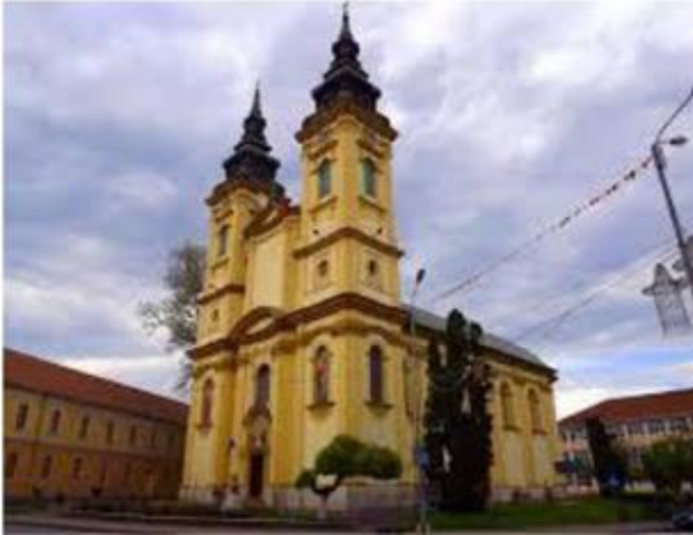
Biserica Adormirea Maicii Domnului din Lugoj, după renovarea din 2014
