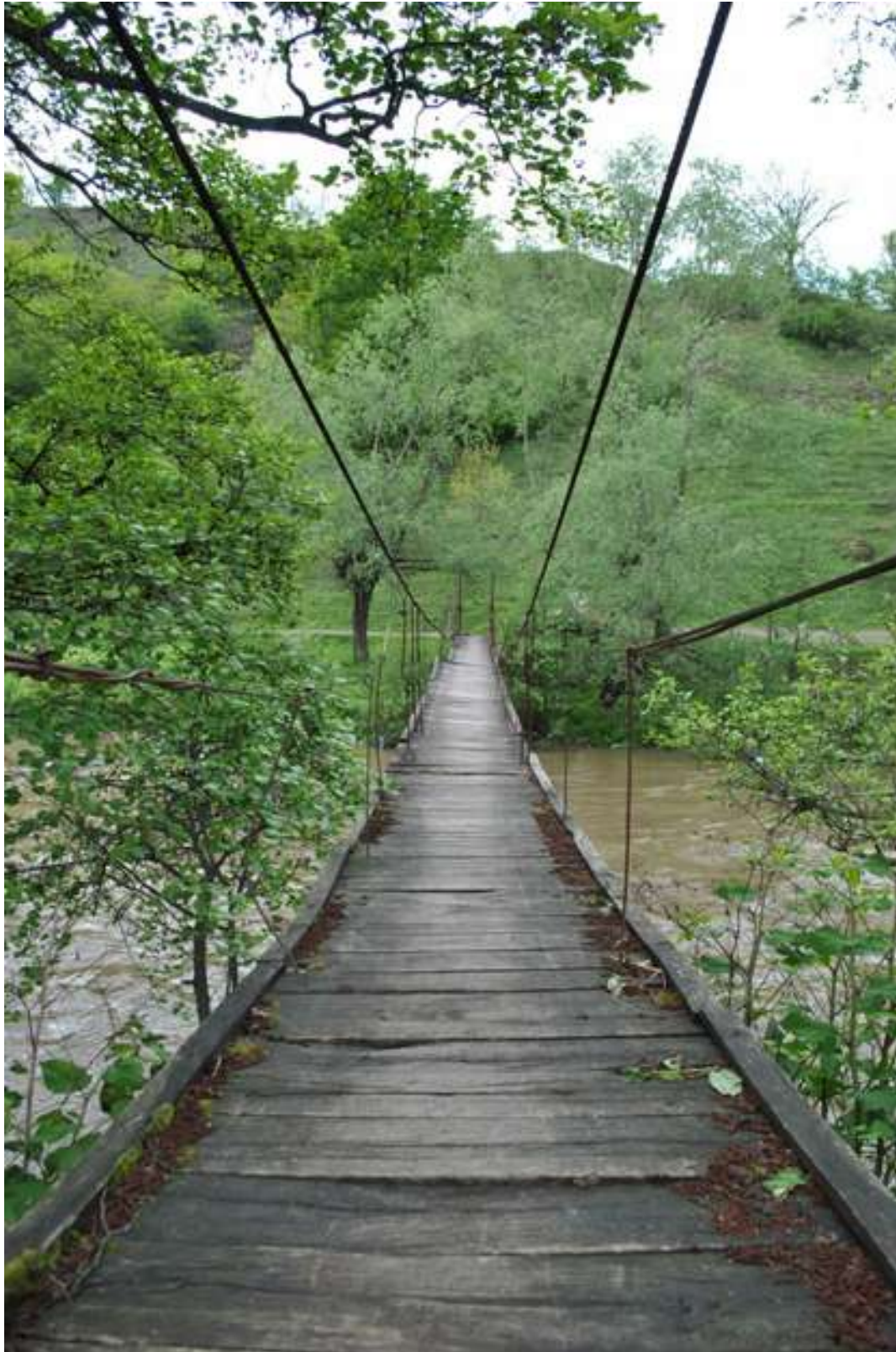
F. 55. Puntea pe cabluri, spre halta C.F.R. (Foto April. 2016 Anca Țerei)
