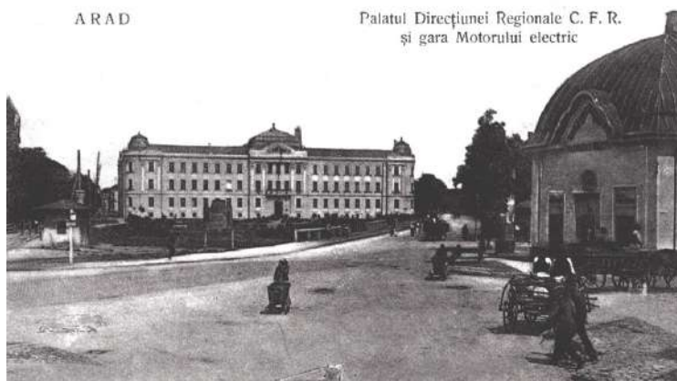
Cele două clădiri feroviare emblematic ale Aradului: Gara electrică construită în 1906 și Palatul Direcțiunii Regionale de Căi Ferate, inaugurat în 1913
