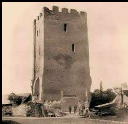
turnul medieval în timpul lucrărilor de reabilitare (inceputul secolului XX)
