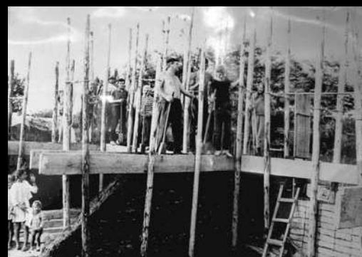
Edificarea unei case slovace din pământ bătut (anii '50-60)
