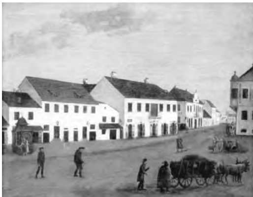
Arad, casa Hirschl, pictură naivă de epocă
