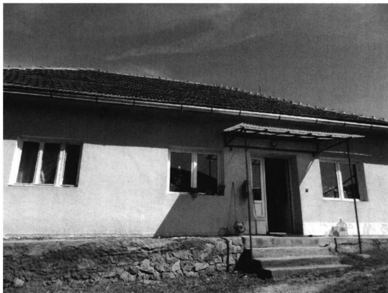
Fosta clădire a școlii din Toplița
