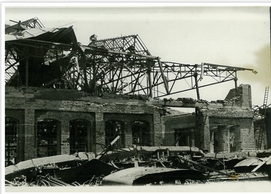
Fig. 21. Atelierele C.F.R. Arad. Strungăria distrusă. Structura metalică a rezistat în fața exploziilor.
