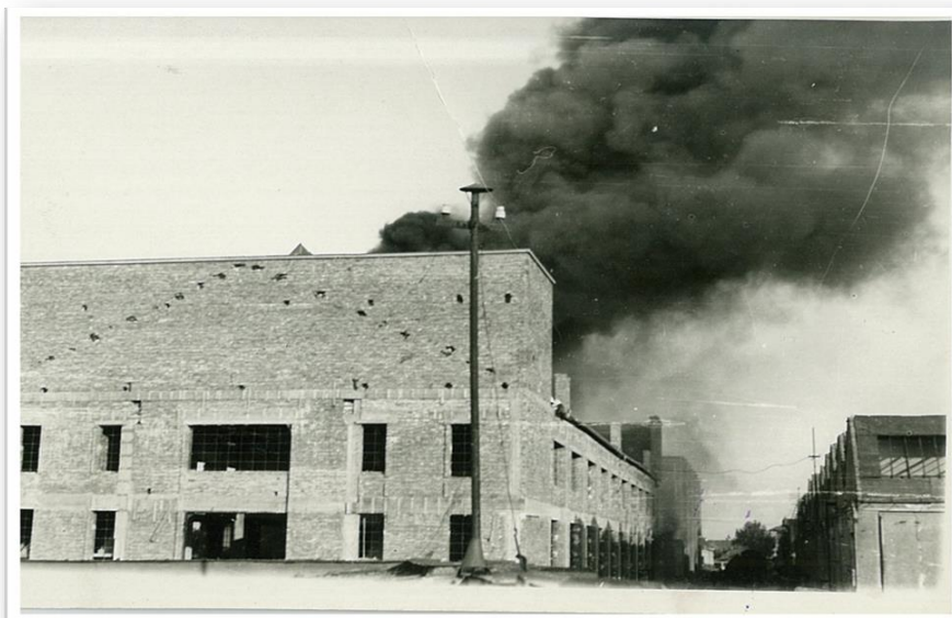
Fig. 1. Atelierele C.F.R. Arad. Secția Piese de schimb. Fumul provine de la depozitul de carburanți situat în spatele clădirii.
