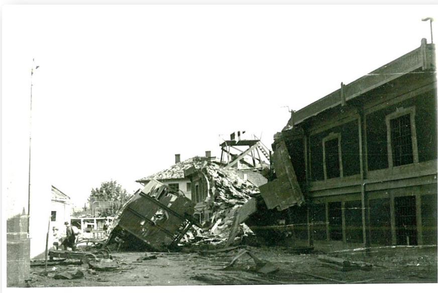
Fig. 25. Atelierele C.F.R. Arad. Magazia de materiale cu un post de observație pe acoperiș. Atelierele C.F.R. Arad. Secția de locomotive a fost intenționat decopertată pentru a fi ferită de incendii.
