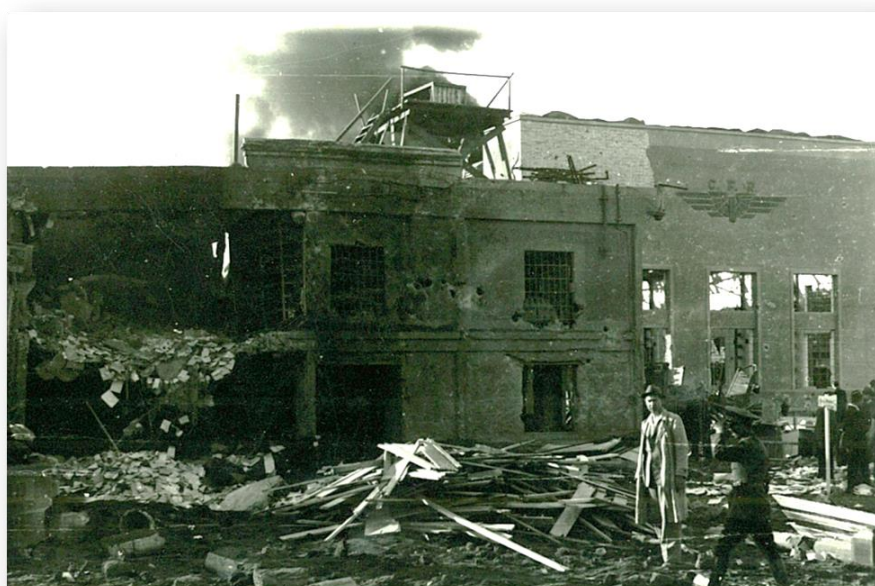
Fig. 21. Atelierele C.F.R. Arad. Strungăria distrusă. Structura metalică a rezistat în fața exploziilor.
