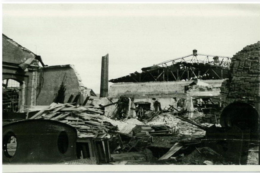
Fig. 2. Atelierele C.F.R. Arad. Vagonajul distrus de bombe brizante a căror combustie este atât de rapidă, încât suflul gazelor produse poate distruge corpurile înconjurătoare.
