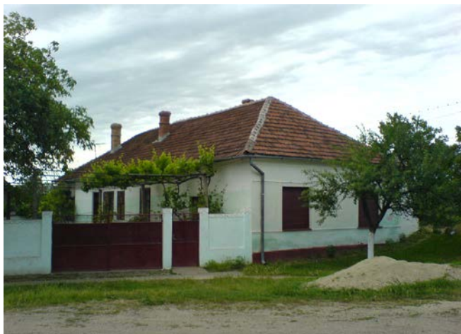
Casa parohială, localul școlii
