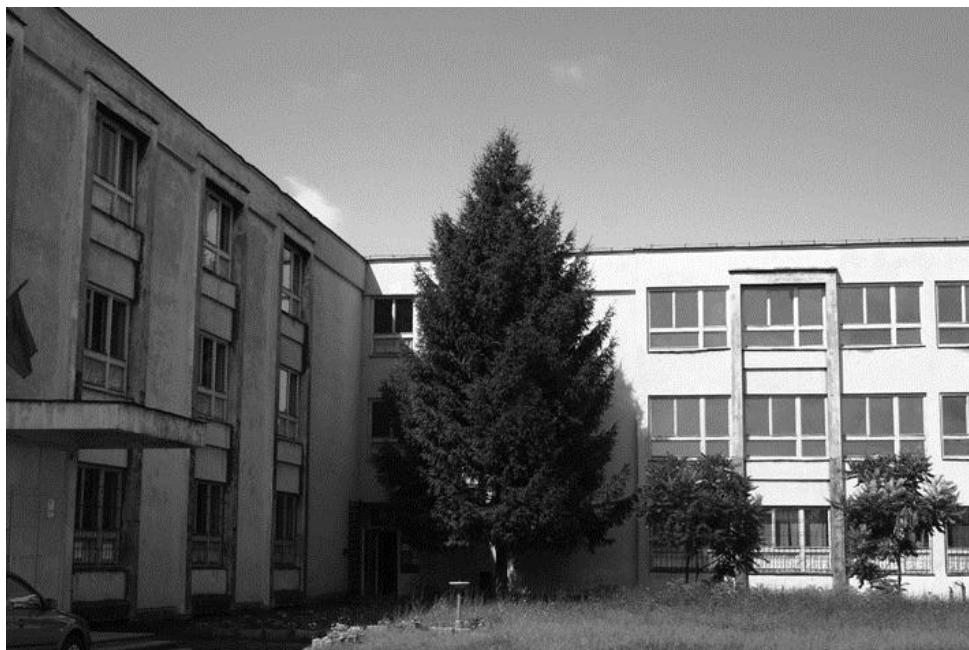
Fosta Școală Generală Nr. 22 de pe str. Posada
