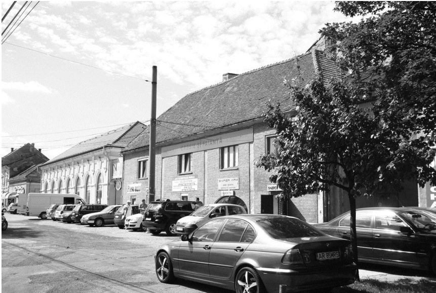
Fabrica baroanei, imagine exterior
