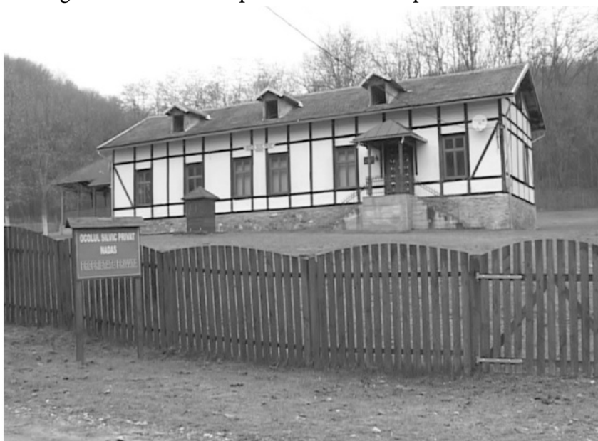
Clădire administrativă rămasă de la Fabrica de cherestea, pe Valea Ceșa (imagine din 2015)
