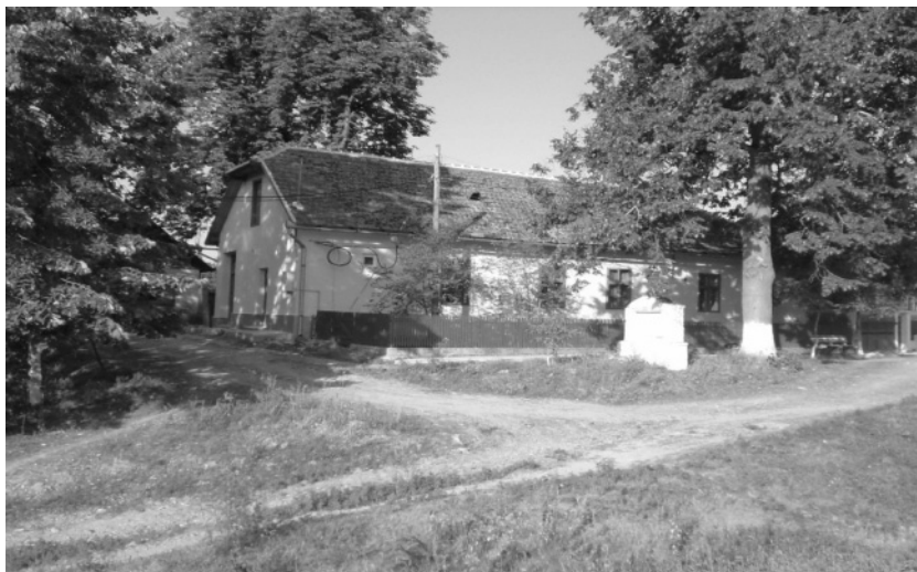
Fosta primărie din Nadăș
