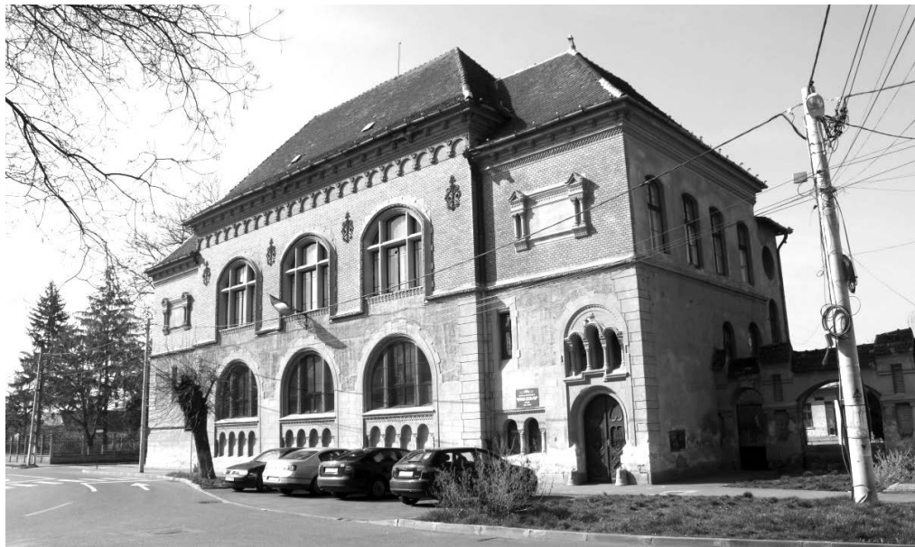
Clădirea Școlii Evreiești (Strada Cozia)
