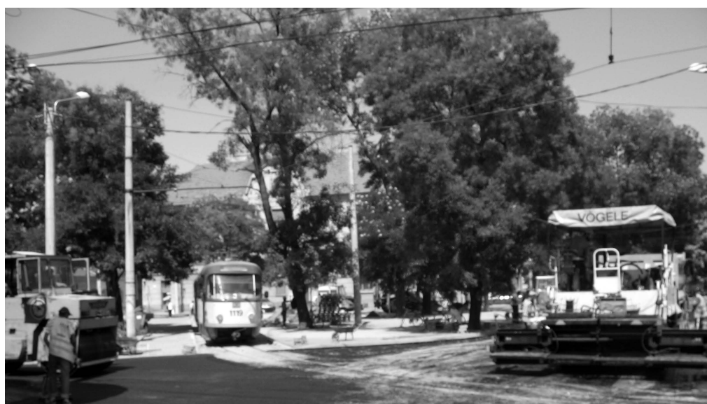
Lucrări în Piața Sârbească (2009)
