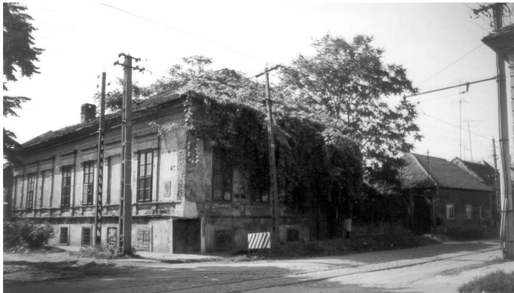
Clădirea Rehcops Haus (strada Preparandiei)
