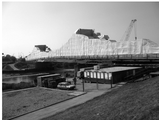
Lucrări de reparații la Podul Traian (2011)
