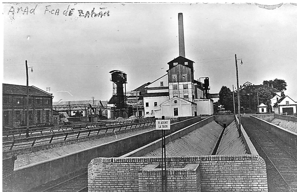
Canale de depozitare și spălare (1935)
