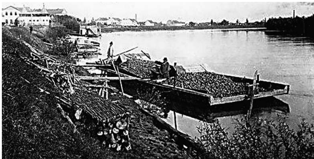
Barjă cu fundul plat acostată la mal
