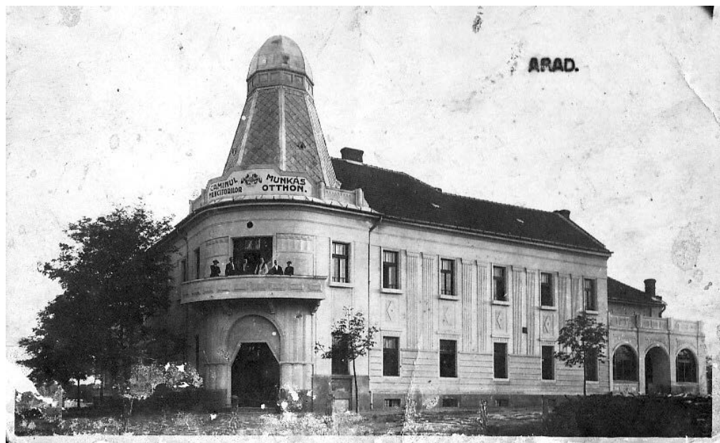
Clădirea fostului Cămin al Muncitorilor
