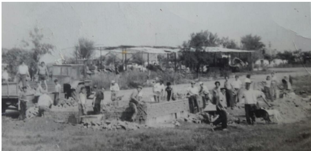
Construcția actualei baze sportive
