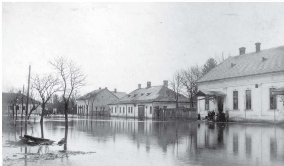
Inundaţii – strada Înfrăţirii
