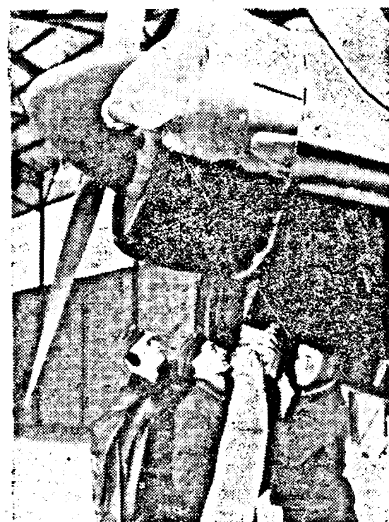
Pe un aerodrom german: Motoarele sunt puse în mișcare prin pomparea de aer cald pentru a grăbi aprinderea
