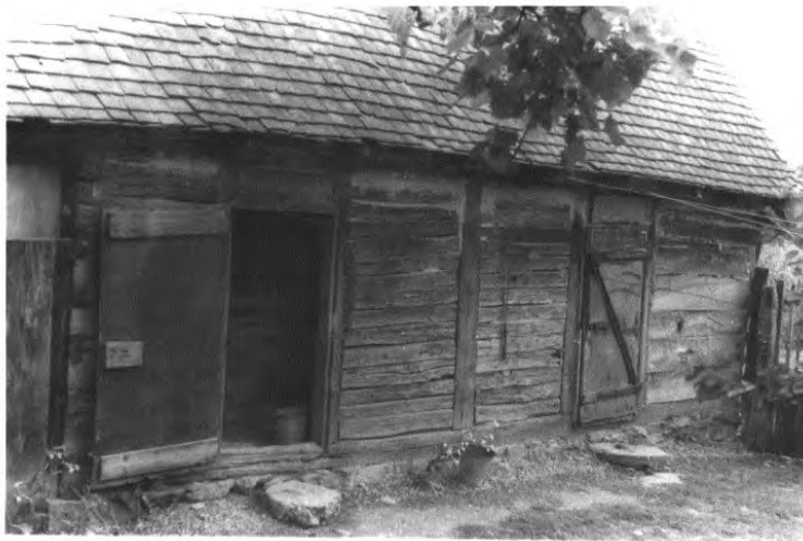
Foto 24. Construcție anexă — grajd din lemn. Se observă modul de realizare a îmbinărilor construcției
