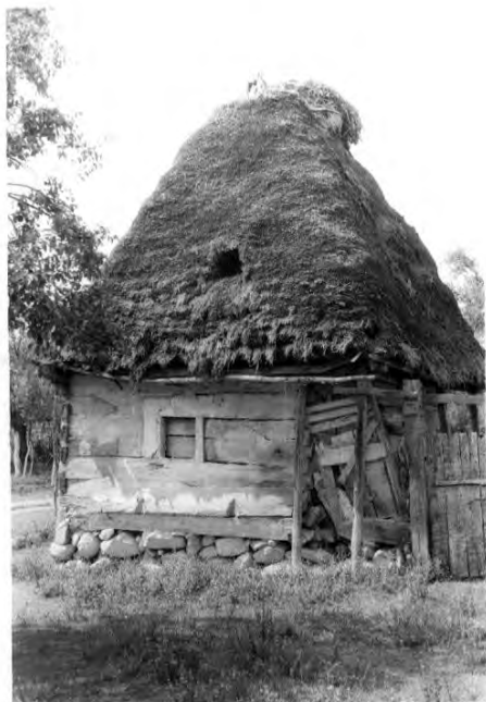
Foto 3b. Aceeași construcție vedere dinspre intrare
