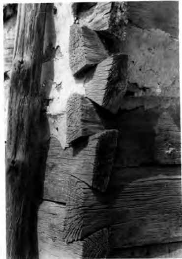
Foto 3b. Aceeași construcție, detaliu de îmbinare în coadă de rândunică
