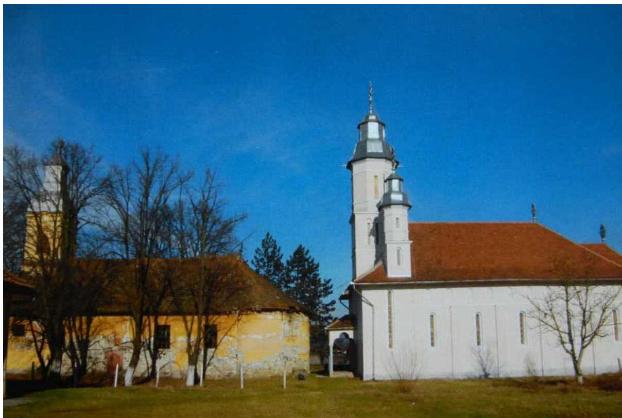
Anul 2012. Cele două biserici ortodoxe ale satului, cu poziția celei vechi, înainte de demolare.
