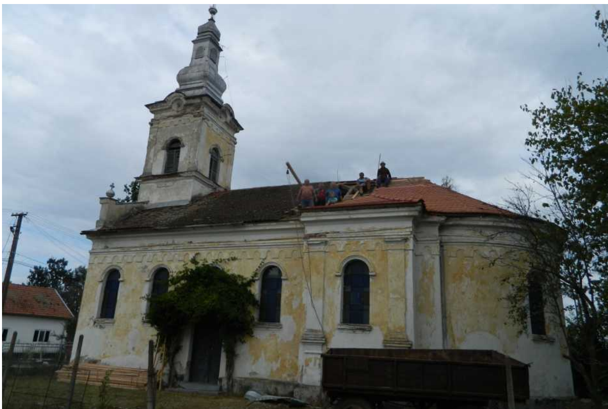
Anul 2019. Lucrări de reparație la Biserica din Voivodeni.
