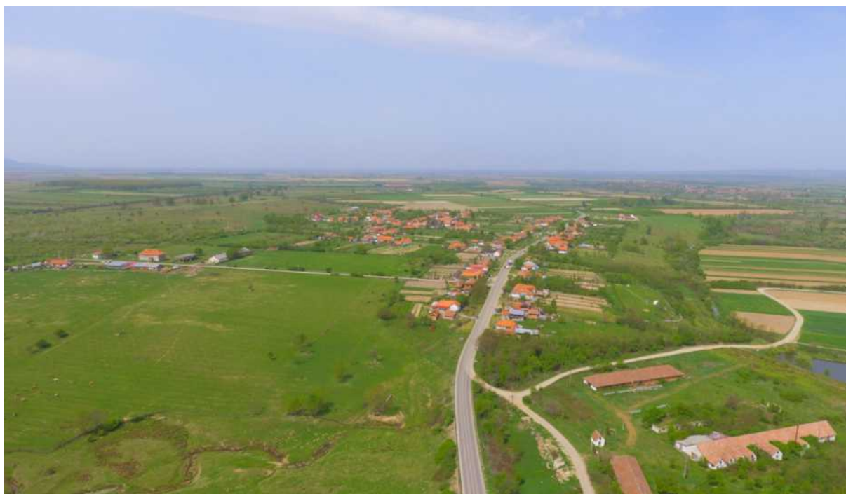
Anul 2020. Drumul Național dintre Aldești și Voivodeni, cu varianta drumului local spre Crișul Alb.
