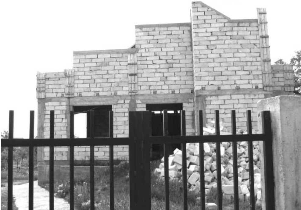
Biserica Apostolică Penticostală în construcție
