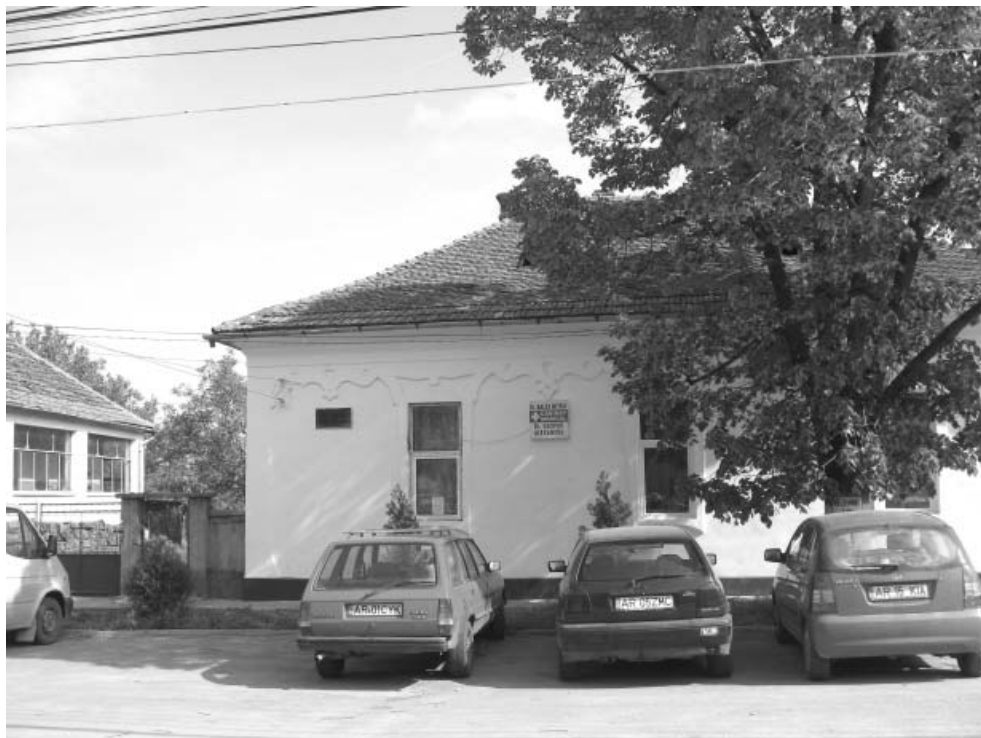
Clădirea dispensarul comunal 2012
