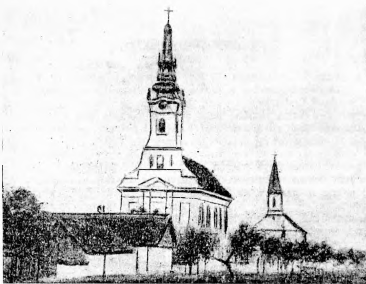
Nădlac - Biserica ortodoxă înainte de restaurare, când mai existau încă clădirile vechi țărănești din pământ bătut, acoperite cu trestie, apoi gardul de zid acoperit cu „tului” (știuleți)
