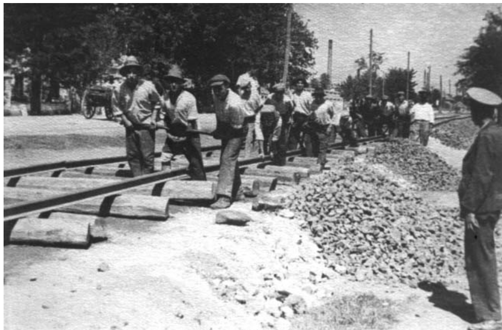
Construcția liniei de tramvai electric (1946)
