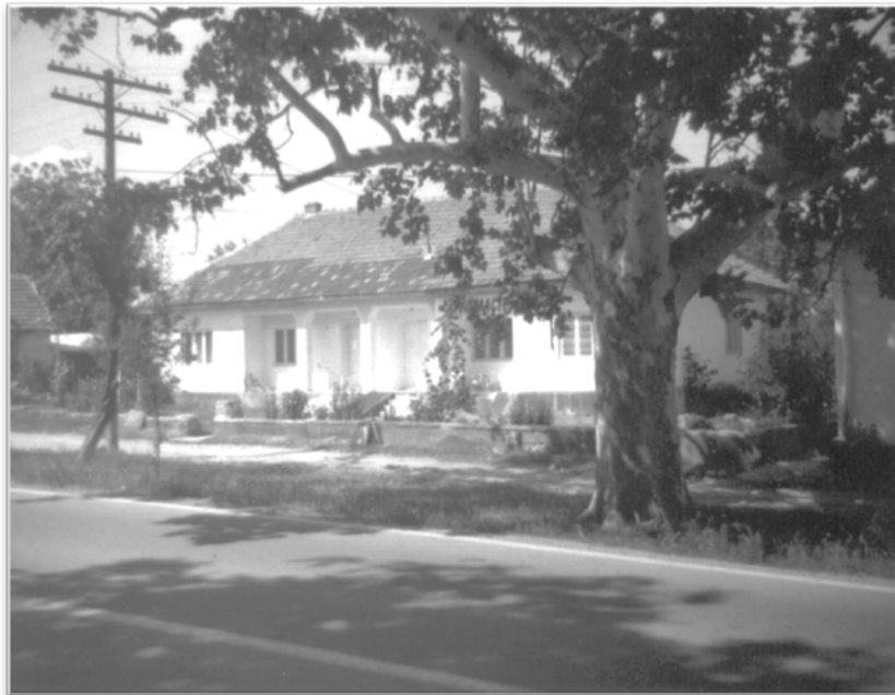
Dispensarul comunal din Bârsa
