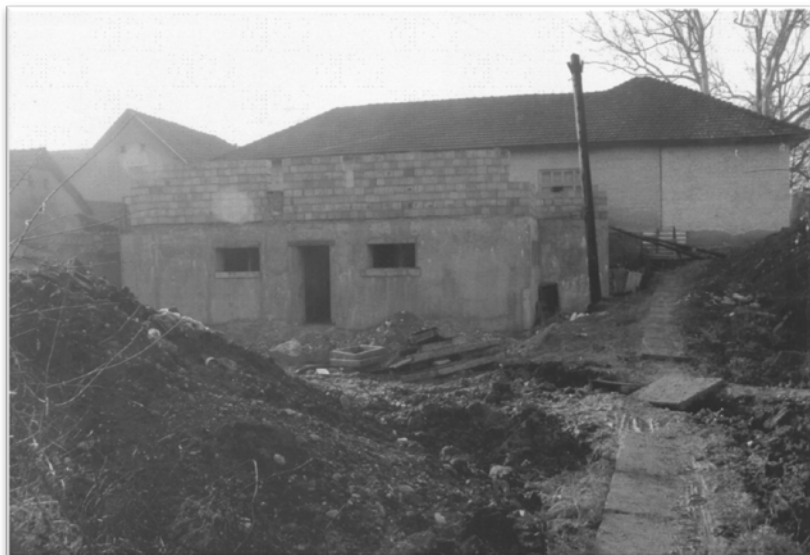
Bârsa. Reconstrucția căminului cultural
