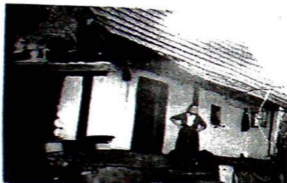
Casa loc. Herbei Vasile, nr. 74. Construită din bârne, pe butuci. Acoperiș în două ape, 1980.
