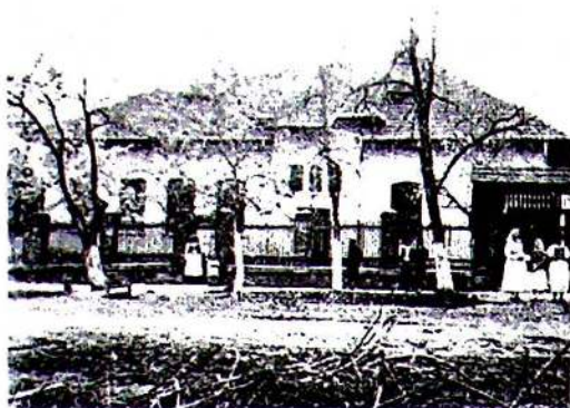
Noul local de școală construit în 1929-1930 -1938
