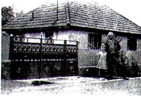
Casa locuitorului Mancu Iancu, 1982
