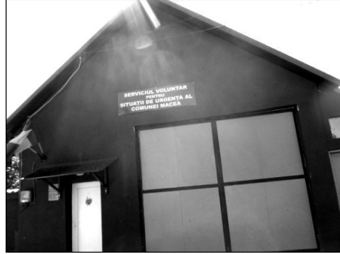
Clădirea formației de pompieri - 2009
