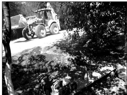
Se lucrează la asfalt - 2009
