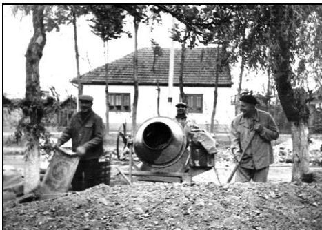
Maistori la betonieră- 1969
