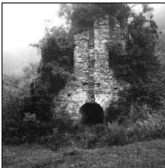
Fig. 6. Zimbru (jud. Arad). Starea de conservare a furnalului în anul 1986
